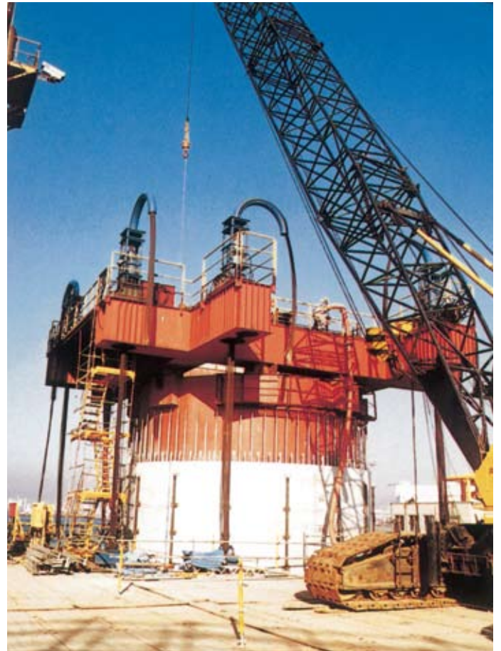
S58～S62 横浜ベイブリッジケーソン
