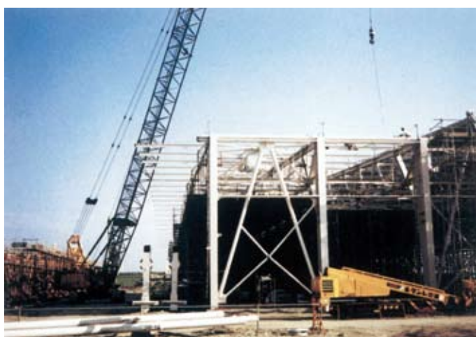
構台上で組み立て中の屋根
