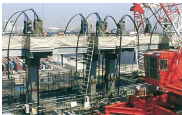
仮設梁上のシブクレーン、ジャッキステージ
