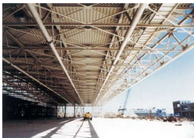
構台前面に引き出された屋根
