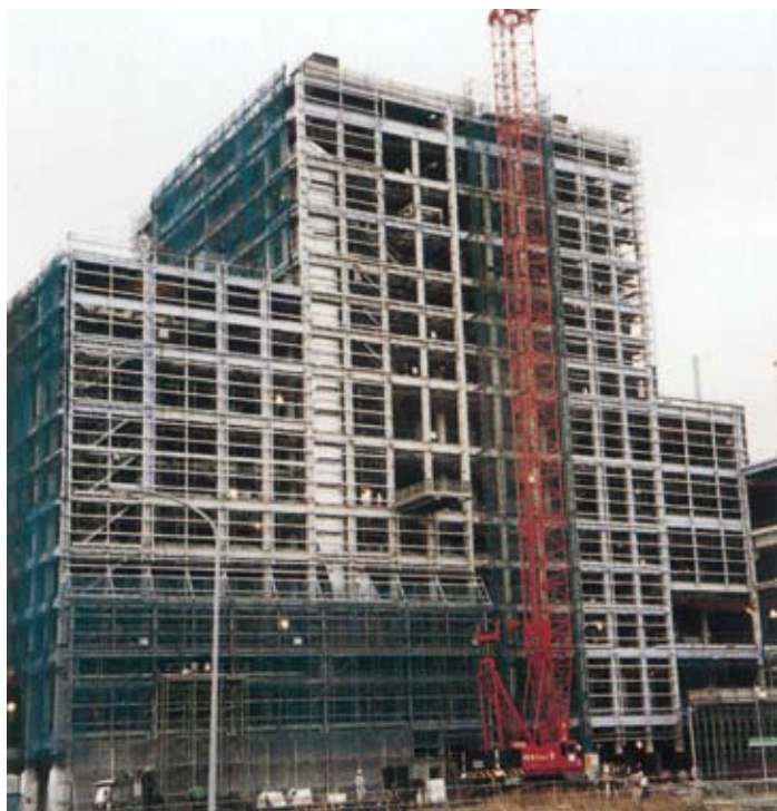
純ラーメン構造を採用したボイラー棟外観
