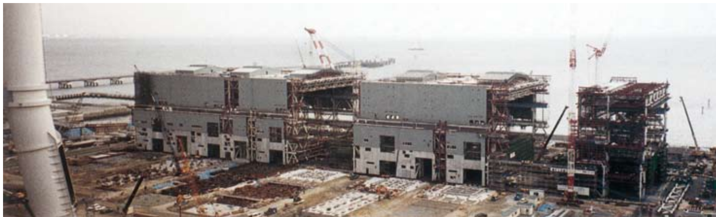
中部電力(株)川越火力4号館工事(6年12月)
