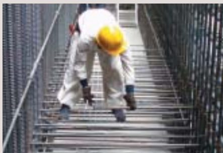
建築物の地下擁壁
