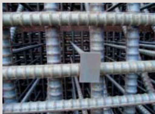
ボックスカルバート壁
