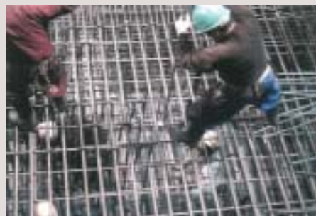
ボックスカルバート床盤
