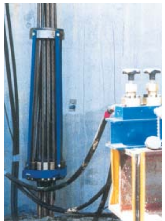
グラウンドアンカーとPCストランドの接続金具及び分岐バルブ
