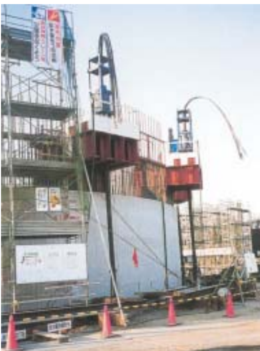
施工中のVSLリフティング装置
