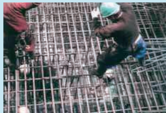
マットスラブせん断補強鉄筋配筋状況
