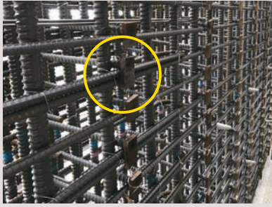
中空橋脚（重ね継手部）
