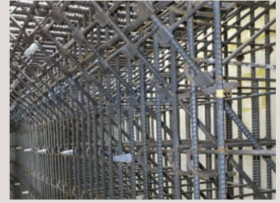
ボックスカルバート（隅角部）
