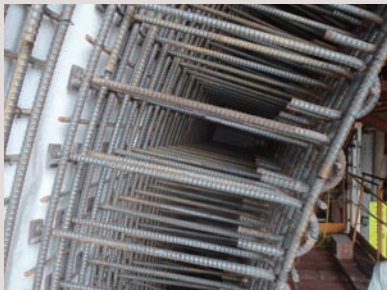
トンネル（アーチ部）
