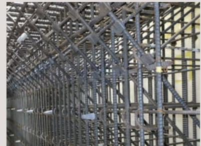
ボックスカルバート（隅角部）
