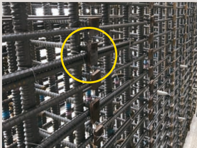
中空橋脚（重ね継手部）
