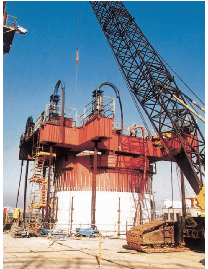
S58～S62 横浜ベイブリッジケーソン
