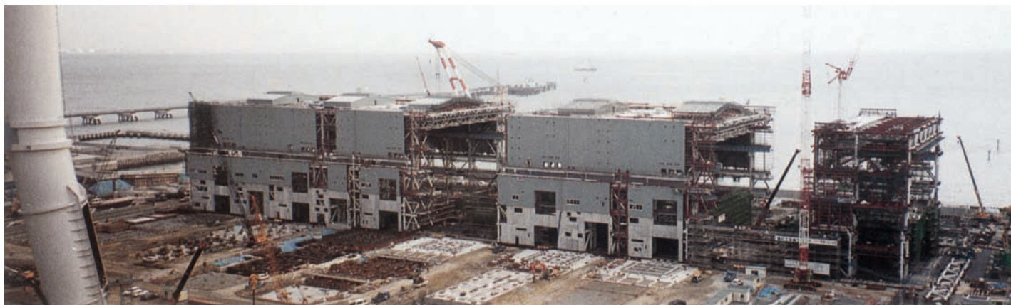
中部電力(株)川越火力4号館工事(6年12月)
