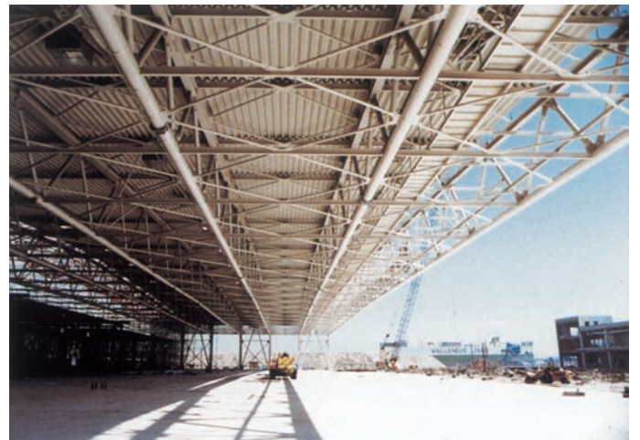
構台前面に引き出された屋根
