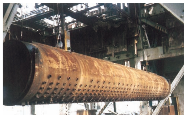
重量140tの蒸気ドラムの降下解体
