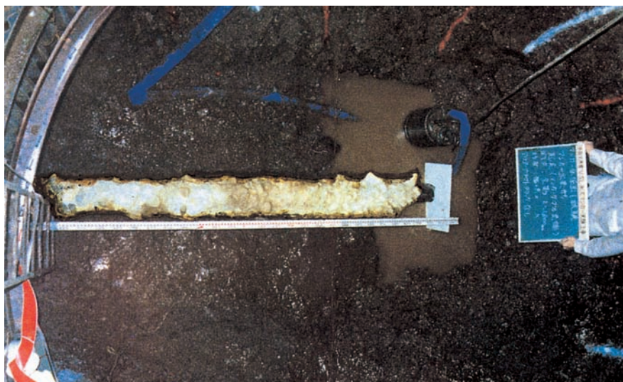
拘束部掘出し
