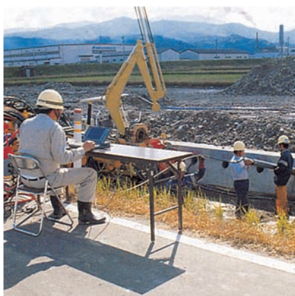
削孔精度の測定
