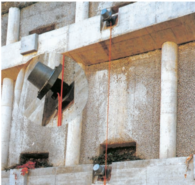
ロードセルによる残存引張り力測定状況
