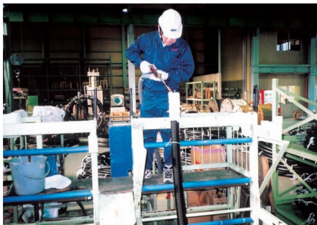
② tendon先端の止水処理の後、エンドキャップを取り付けます。
